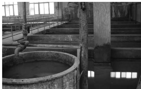
写真6 レアアース分離工程後の廃水処理施設
